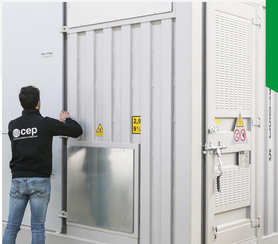
Sono cabine elettriche di trasformazione per utenti privati e sono identificati come monoblocchi tridimensionali costituiti da una struttura in acciaio basata su un container 20' standard ISO.
